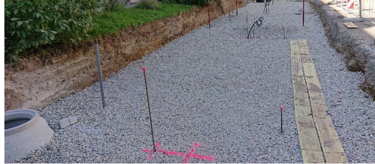
Belüftungs- und Verteilschicht
