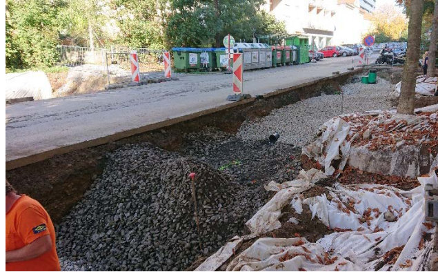
Variante 1: Wurzelraumverbesserung mit vorgemischtem Schwammstadtsubstrat
