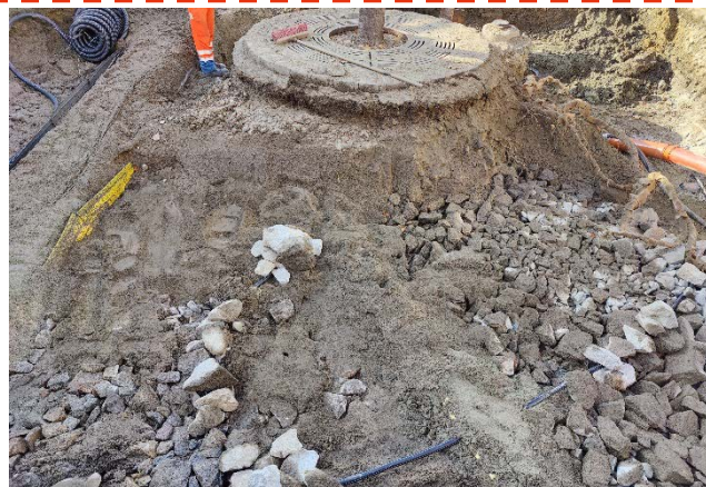
Variante 2: Wurzelraumerweiterung mit ingeschlämmtem Schwammstadtsubstrat
