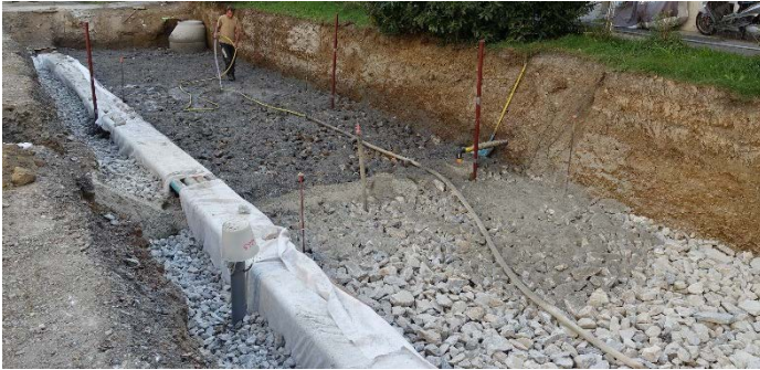
Eingeschlämmtes Schwammstadtsubstrat
